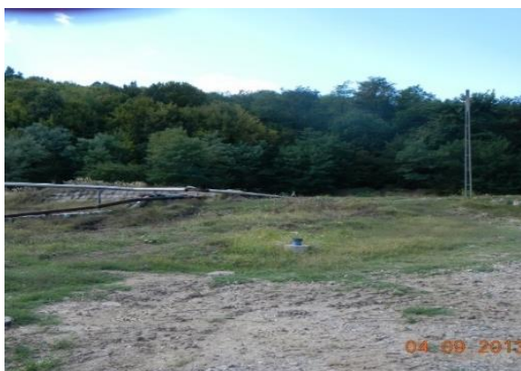
Înainte de recuperare
