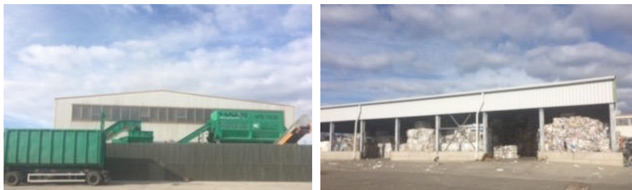
Figura 4-5: Stația de sortare Aninoasa
